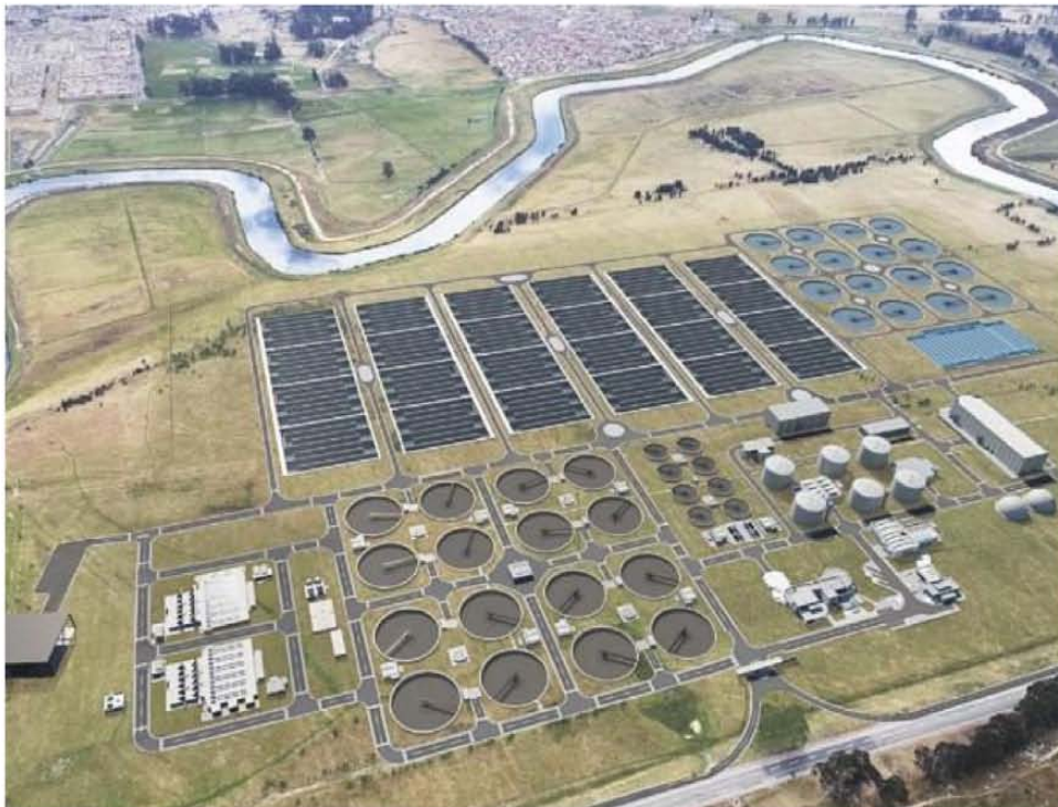
En las plantas de tratamiento de aguas residuales no se están eliminando estos residuos
