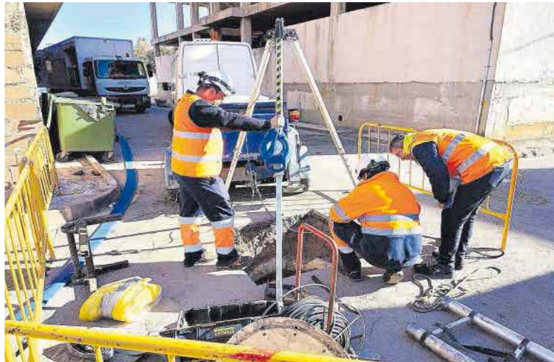
Imagen de los trabajos de colocación de enfundados en las tuberías de saneamiento.
