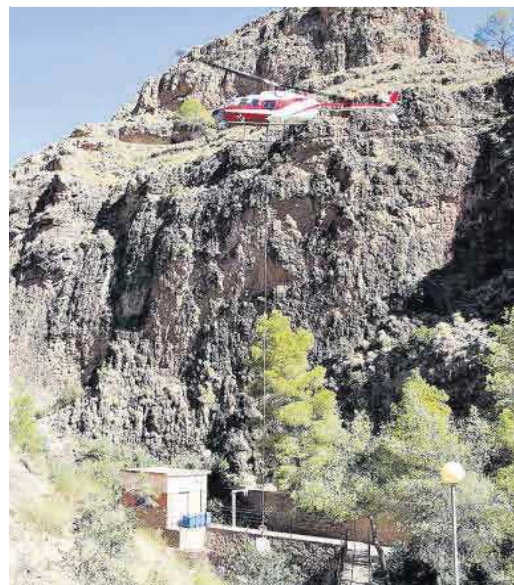
Un momento del traslado de materiales para mejorar la instalación.
